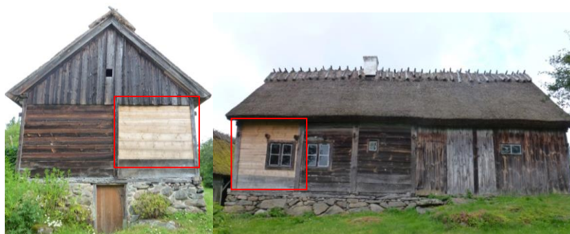
Södra gaveln och östra långsidan. De markerade partierna är ersatta 2014.
