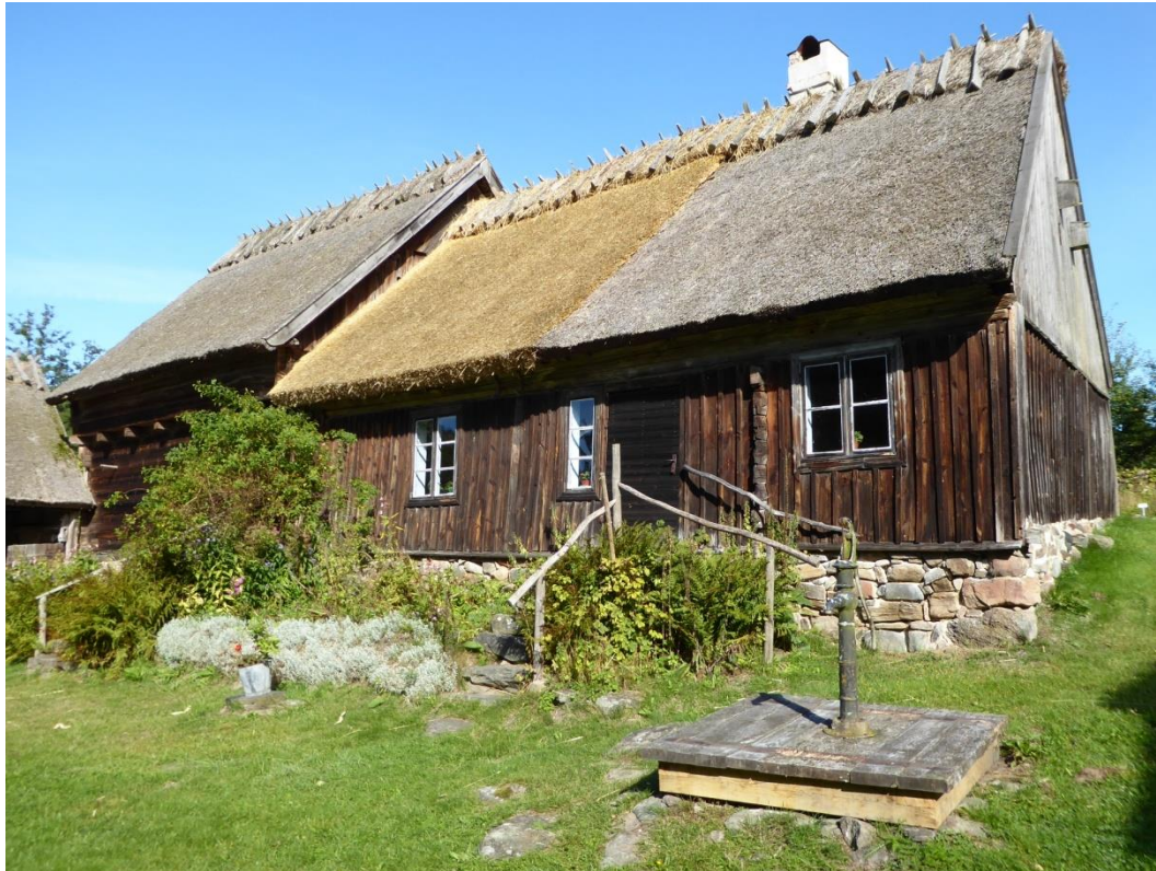
Boningslängan sedd från sydost.
