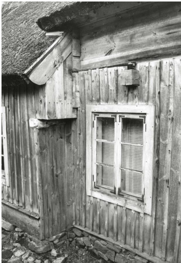
Foto 1965 av S. Hjalmarsson och Nils-Arvid Bringéus. Boningslängan sett från norr, mötet mellan boningshuset och härbergshuset. Fotografi från Skånes Hembygdsförbund. Original i Folklivsarkivet.
